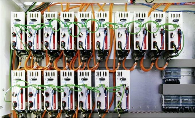
Blick in den zentralen Schaltschrank der Twins-Transferanlage, auf der Kleinteile für Gasarmaturen gefertigt werden. Insgesamt fünfzehn 2-kanalige und zwei 1-kanalige EtherCAT-Servoantriebsverstärker des Typs AX5xxx sind zur Ansteuerung der Achsen im Einsatz.
